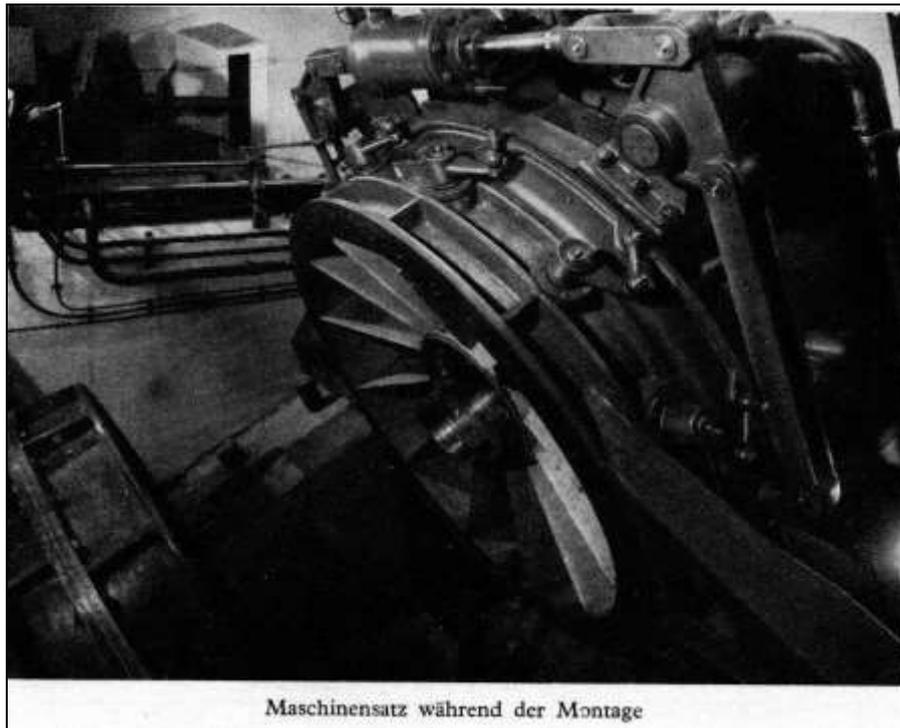
**Bild 132: Eine der drei Arno Fischer-Turbinen des Saalachkraftwerkes Rott.**
