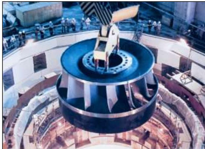
**Bild 11: Laufrad einer Francis-Turbine max. 800 MW des Kraftwerkes Itaipu.<sup>73</sup>
